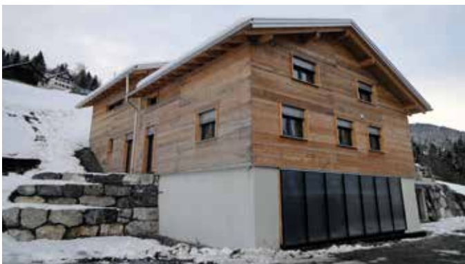
Sanierung/Umbau des bestehenden Haus- und Stallgebäudes im Mittleren Bonacker
