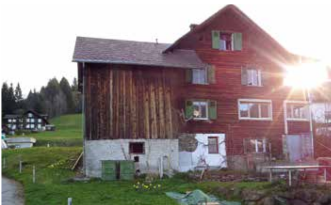
Das Haus vor dem Umbau
