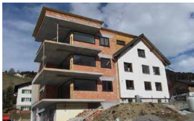
Umbau in der Unterwaldstraße bei Fam. Nesensohn
