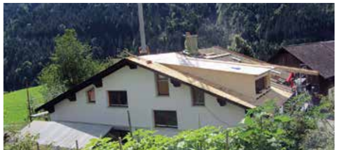
Umbauarbeiten in der Unterwaldstraße
